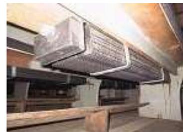
Bild 3: Konvektor über dem Fußboden
